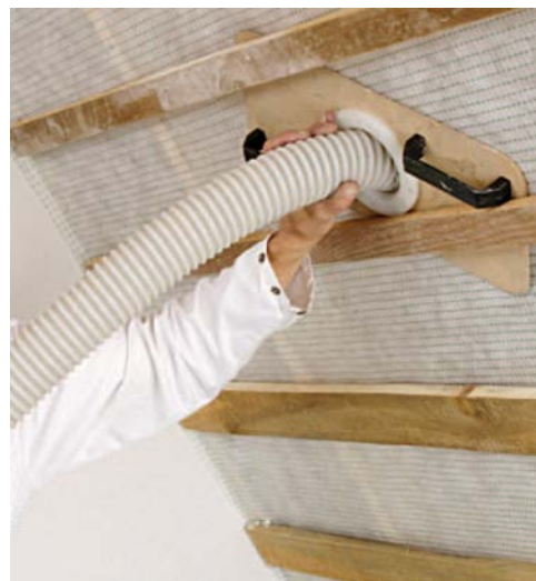
Abb. 2: Einblasvorgang des Zellulosedämmstoffs Thermofloc
