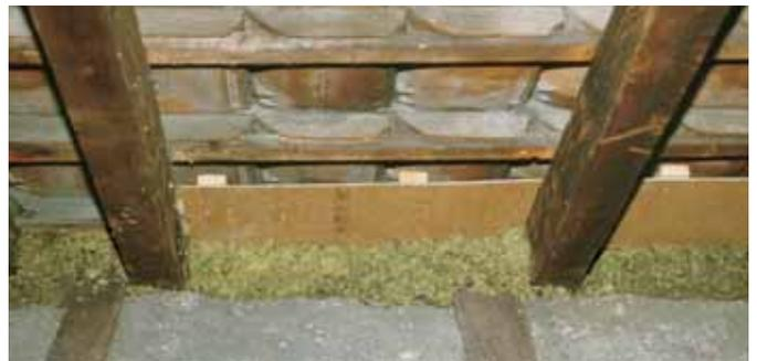
Dachschräge, mit Fillrock RG gedämmt (mit Hinterlüftung)
