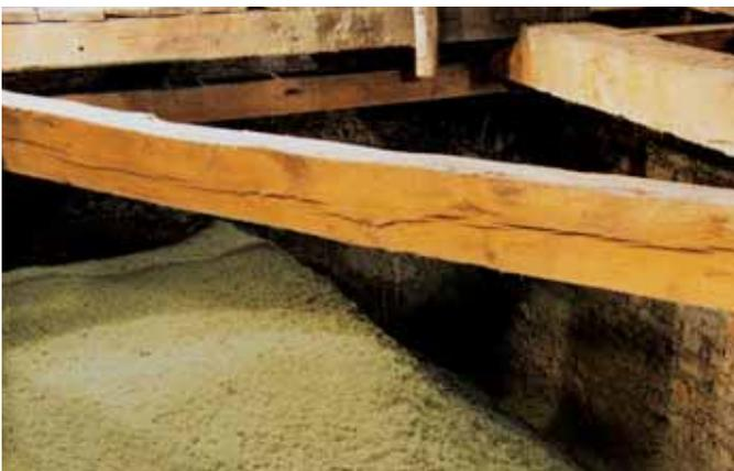
Abrutschsicher aufgebaute Dämmschicht Fillrock RG
