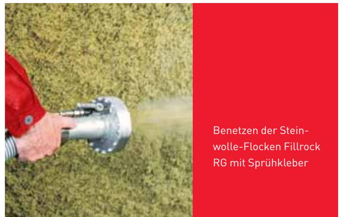
Benetzen der Steinwolle-Flocken Fillrock RG mit Sprühkleber
