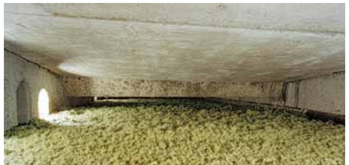
Belüftetes Flachdach, mit Fillrock RG gedämmt
