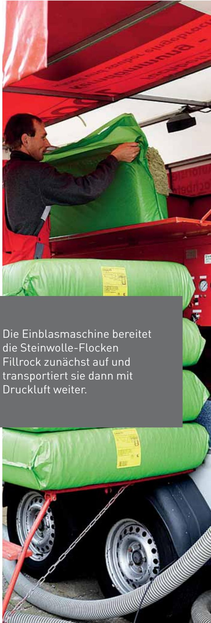
Die Einblasmaschine bereitet die Steinwolle-Flocken Fillrock zunächst auf und transportiert sie dann mit Druckluft weiter.
